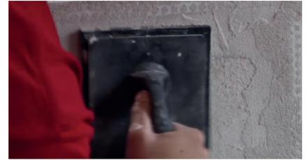
**3** Appliquez une couche homogène d'enduit Skamol Structural Plaster de 2 à 8mm d'épaisseur.
