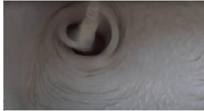
**2** Mélangez l'enduit Skamol Structural Plaster avec de l'eau, conformément au taux de mélange spécifié.
