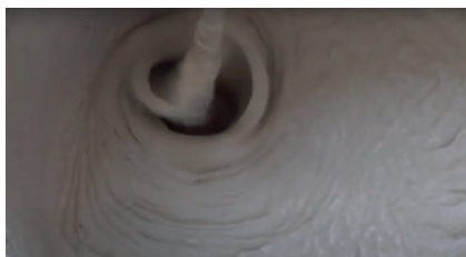
2 Mix Skamol Structural Plaster med vand efter det angivne blandingsforhold.
