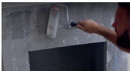
1 Klargør SkamoEnclosure Board.
