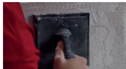
3 Påfør Skamol Structural Plaster i en jævn tykkelse på 2 til 8mm.
