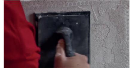
**3** Нанесите Skamol Smooth Plaster ровным слоем толщиной 1,5-3мм.
