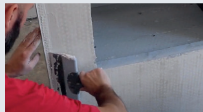
3 Îndepărtați excesul de tencuială.
