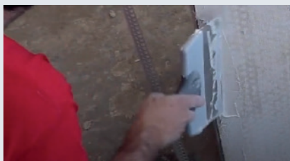
2 Aplicați tencuiala acolo unde se folosește colțul Skamol Corner.
