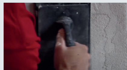
3 Nakładanie tynku można rozpocząć po 30 minutach od nałożenia preparatu gruntującego Skamol Primer.
