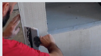
3 Wyrównać nadmiar tynku.
