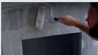
2 Nałożyć preparat gruntujący Skamol Primer na powierzchnię płyty SkamoEnclosure Board w miejscu późniejszego nakładania tynku.
