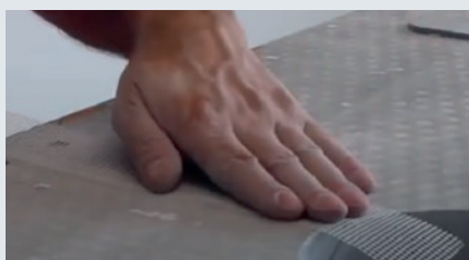
1 Nałożyć taśmę łączącą Skamol Joint Tape.
