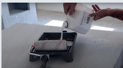
1 Preparat gruntujący Skamol Primer jest gotowy do użycia.
